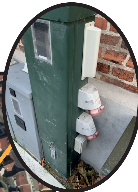
På Torvet 6 x CEE 2 x 32 Amp 1 x 16 Amp
